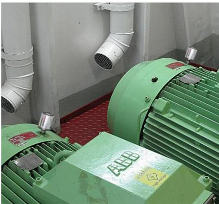
ABB 전기 모터에는 simalube 60ml 자동 주입기가 장착되어 있습니다.
