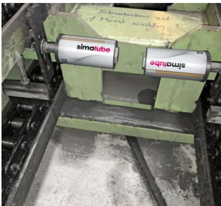
브러시를 포함한 simalube 자동주입기는 컨베이어에 설치되어 지속적인 윤활과 동시에 청소됩니다.
