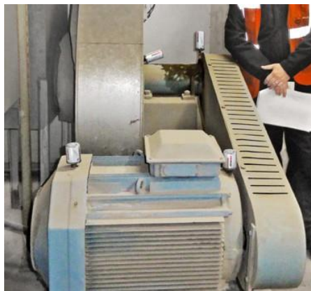
연소 환풍기는 2개의 simalube 60ml 및 125ml 자동주입기로 윤활됩니다.
