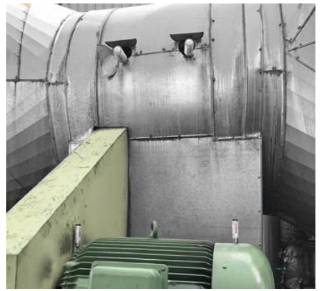
환기 장치의 베어링은 simalube 125ml 및 15ml 자동주입기로 윤활됩니다.
